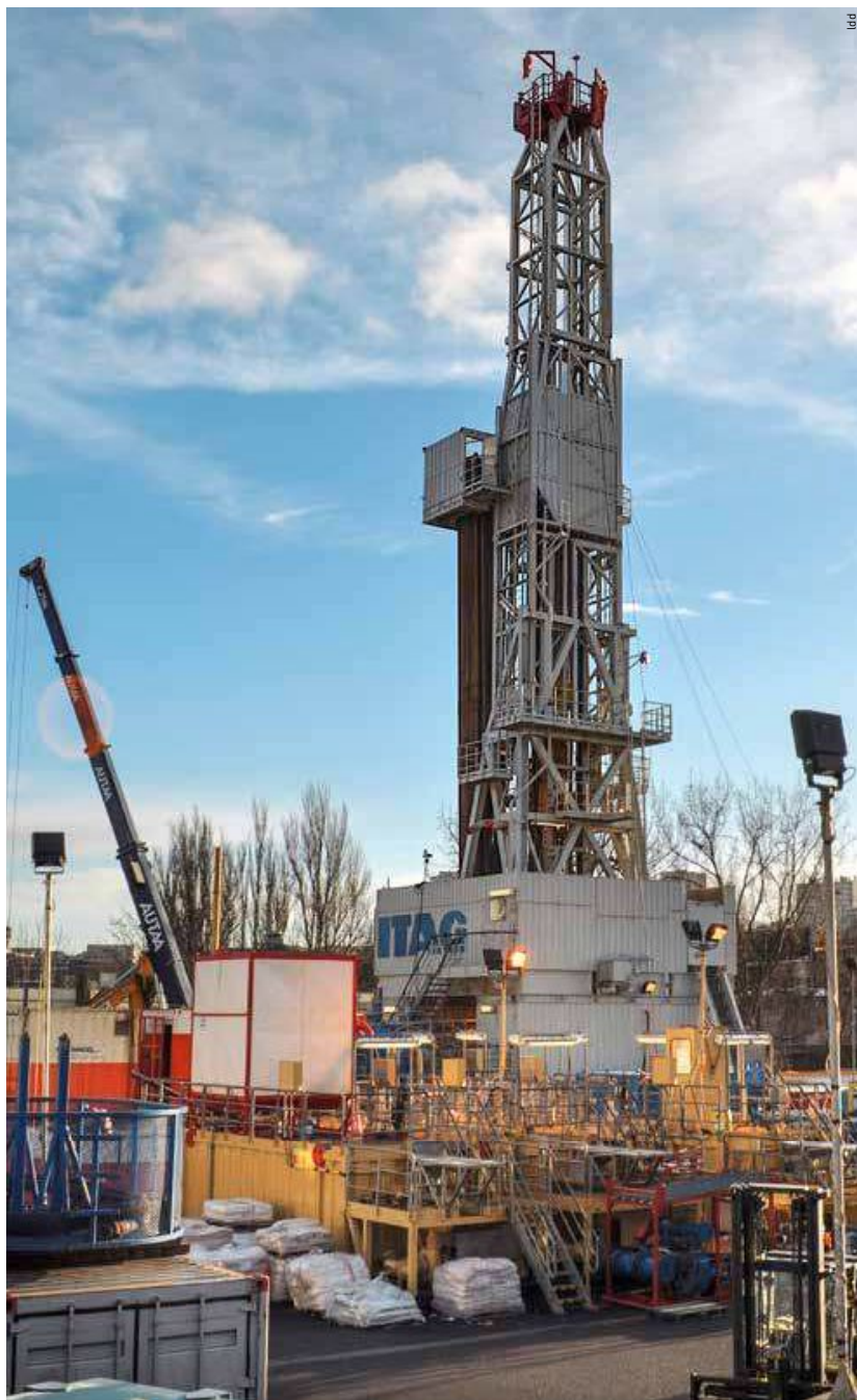
Forage géothermique à Arcueil-Gentilly (F).
